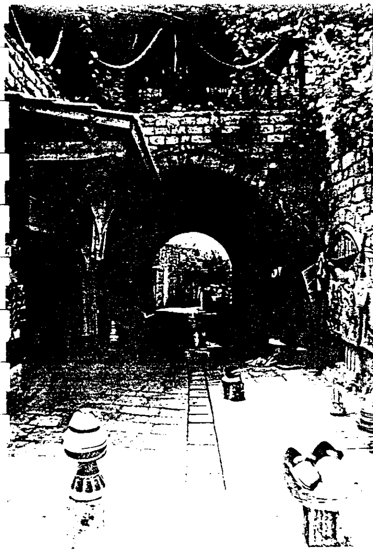
Passage sous voûte
