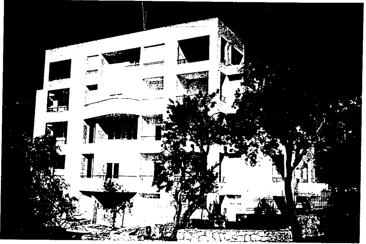
بناء حديث من عدة طبقات ذات مستوى جيد
