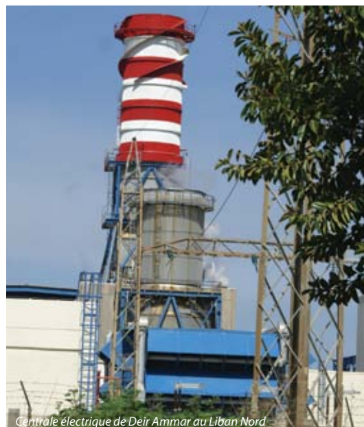
Centrale électrique de Deir Ammar au Liban Nord
